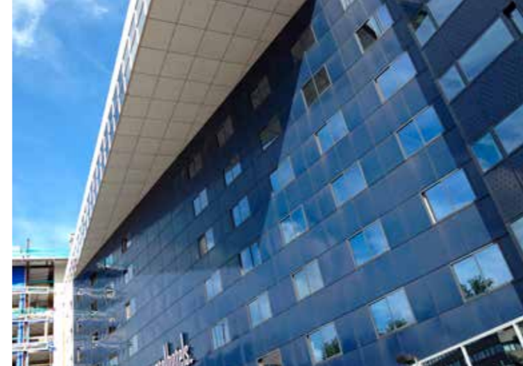
De gevel van het Mainport Hotel, voor en na het beplakken met folie. Foto's Façade Groep.
