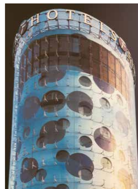
Het eerste grote project van Façade Groep was het beplakken van de gevel van het A2 Fletcher Hotel dat naast de Amsterdam Arena is gebouwd. Foto Wilbert Leistra.
